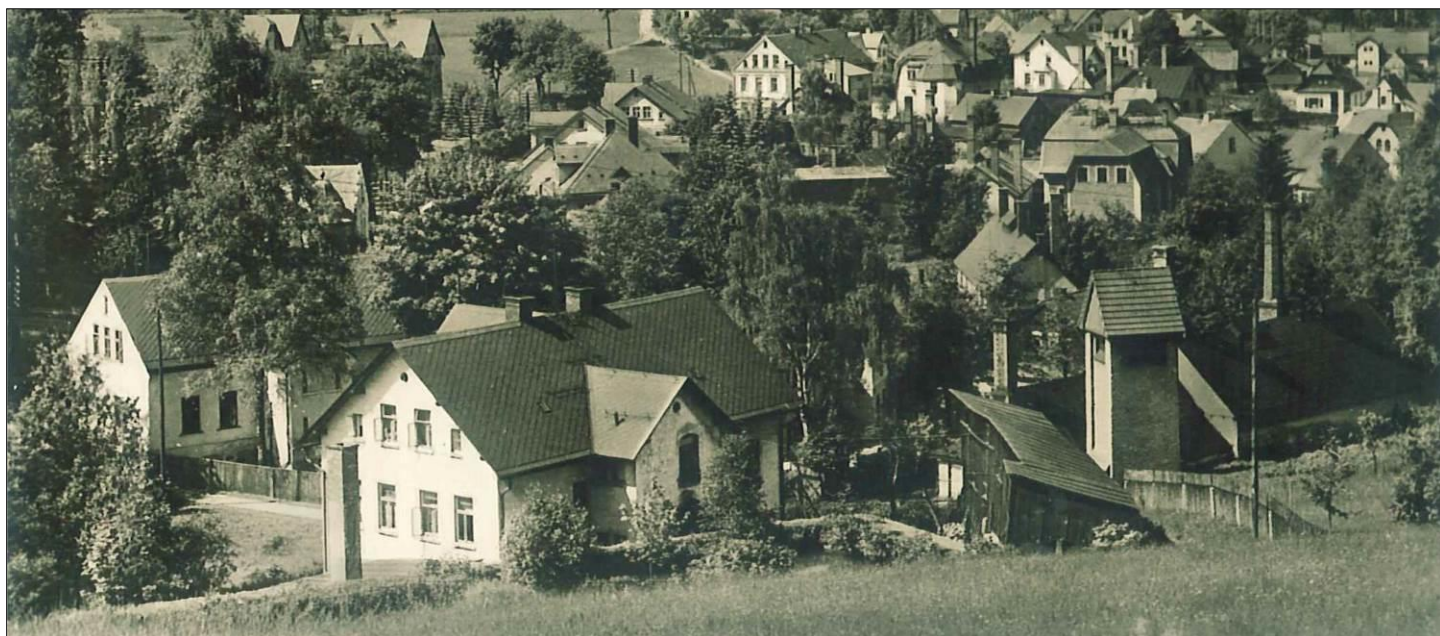
V popředí strojní zámečnictví Otto Posselta se zásobním rybníkem nad domem, nalevo dům čp.218 výrobce skleněných perli Rudolfa Weisse (dnes Huškovi, nedávno rodina Šťastných), napravo za trafostanicí je vidět rozlehlý objekt Weissovi sklářské kompoziční hutě s tahárnou.
