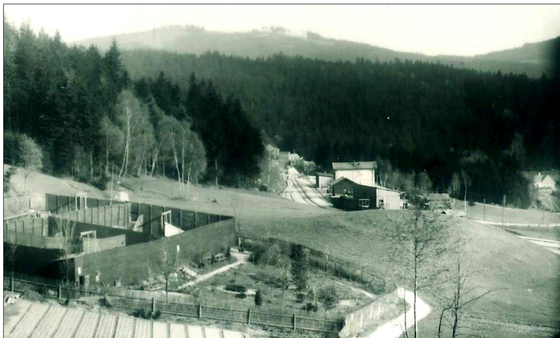
Novoveské nádraží nedlouho po dostavbě, v popředí již dávno zaniklé sluneční lázně.
