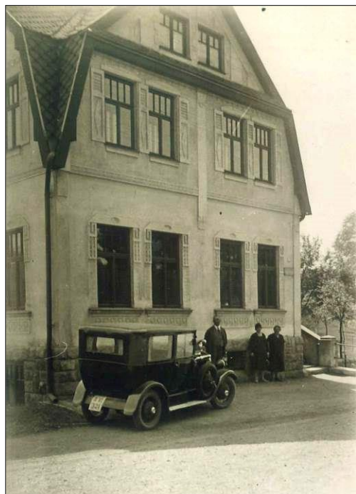
Druhá novoveská pošta, poprvé v letech 1910 až 1918, později znovu v letech 1946 až 1993
