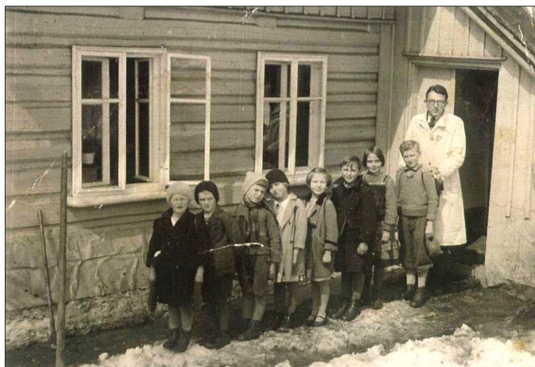
Česká škola v Nové Vsi nad Nisou (1937) Do české mateční školy docházely děti z novoveských a černostudničních českých rodin od roku 1936. Vyučování probíhalo v roubeném stavení čp.262 na stráni vedle vleku. Dům tehdy patřil Josefu Pavlišťovi (dnes Fajkovi). Prvního učitele Jana Sýkoru zanedlouho nahradil Jiří Matějec (na snímku vpravo)
